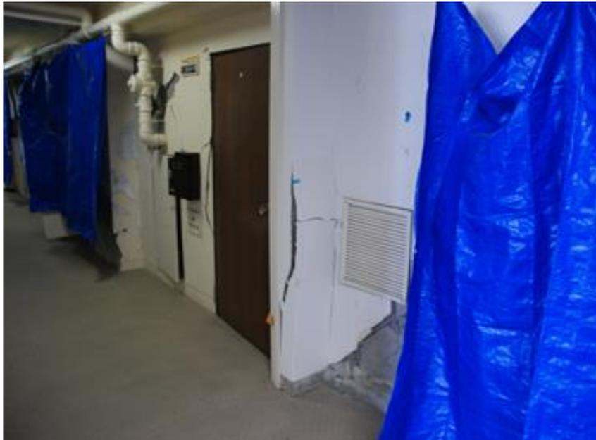
RC造マンションの雑壁が大きく損傷し
