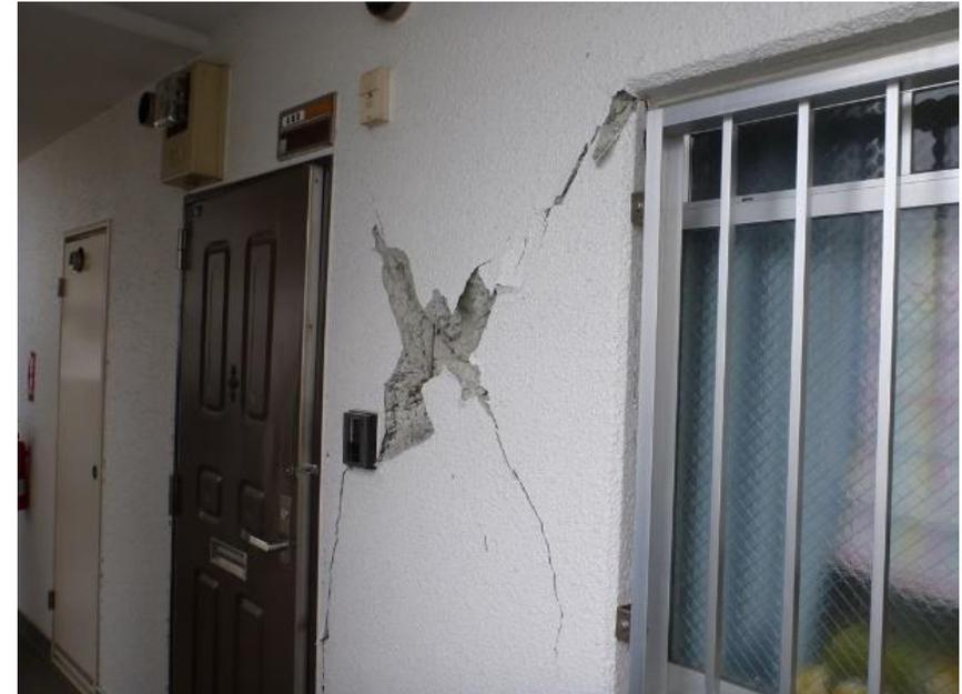
RC造マンションの方立壁が損傷し
